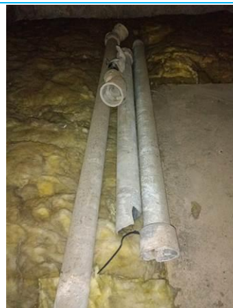
Matériaux : ZPSO-013 Prélèvement : Description : Conduits au sol Localisation : Combles 2 Résultat : Présence d'amiante
