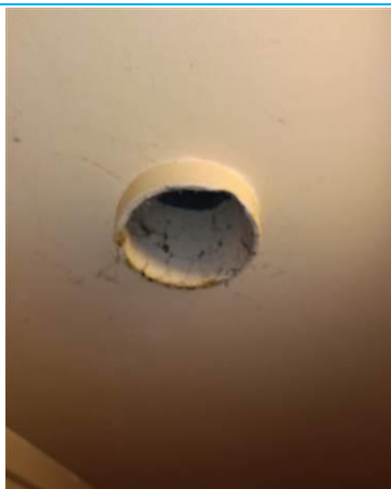
Matériaux : ZPSO-007 Prélèvement : Description : Conduit Localisation : Local technique Résultat : Présence d'amiante
