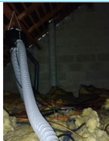
Matériaux : ZPSO-008 Prélèvement : Description : Conduit Localisation : Sanitaires 2; Combles 1 Résultat : Présence d'amiante
