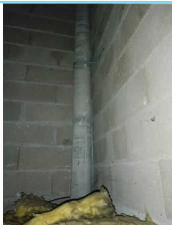
Matériaux : ZPSO-009 Prélèvement : Description : Conduit Localisation : Sanitaires 1; Combles 1 Résultat : Présence d'amiante
