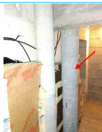
Matériaux : ZPSO-011 Prélèvement : Description : Conduit Localisation : Pièce 1; Combles 2 Résultat : Présence d'amiante
