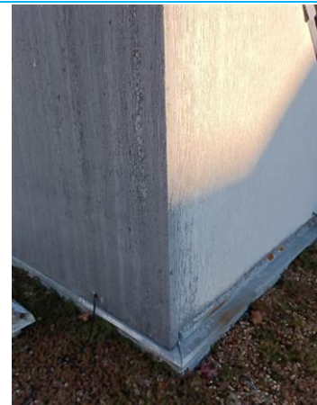
Matériaux : ZPSO-004 Prélèvement : P004 Description : Panneaux de bardage Localisation : Toiture terrasse Résultat : Absence d'amiante
