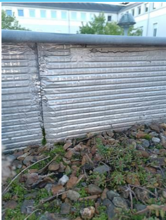
Matériaux : ZPSO-003 Prélèvement : P003 Description : Relevé : revêtement bitumineux Localisation : Toiture terrasse Résultat : Absence d'amiante
