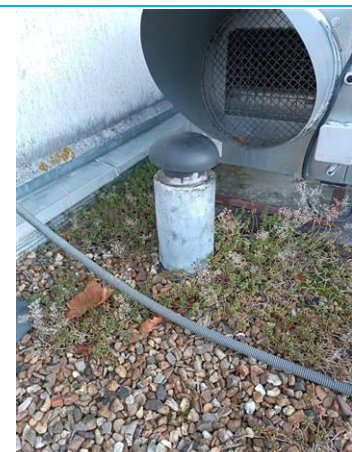
Matériaux : ZPSO-006 Prélèvement : Description : Conduit Localisation : Toiture terrasse Résultat : Présence d'amiante
