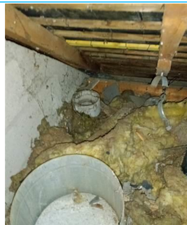
Matériaux : ZPSO-010 Prélèvement : Description : Conduit Localisation : Plonge 1; Combles 2 Résultat : Présence d'amiante
