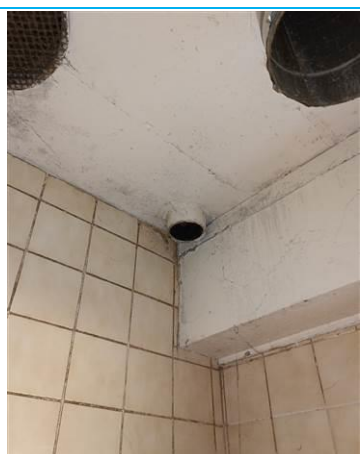
Matériaux : ZPSO-010 Prélèvement : Description : Conduit Localisation : Plonge 1; Combles 2 Résultat : Présence d'amiante
