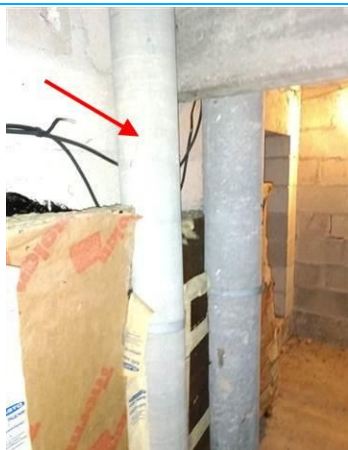
Matériaux : ZPSO-012 Prélèvement : Description : Conduit Localisation : Pièce 3; Combles 2 Résultat : Présence d'amiante
