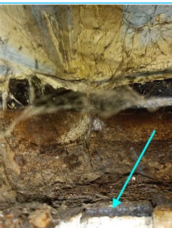
Matériaux : ZPSO-005 Prélèvement : P005 Description : Partie plane : écran de semi indépendance Localisation : Toiture terrasse Résultat : Absence d'amiante
